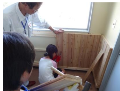
小学校の廊下腰壁材
